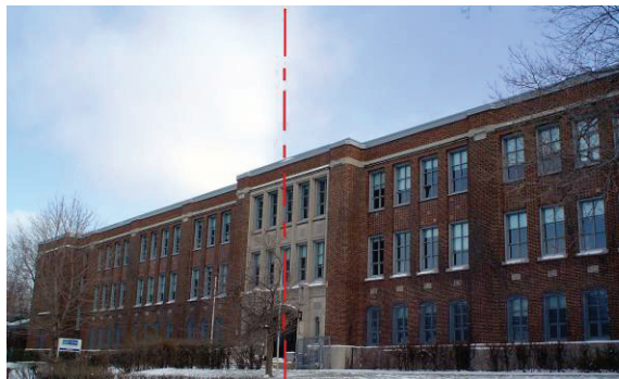
École Iona (1929) : Façade symétrique avec entrée centrale
