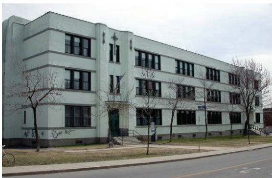
Il s'agit d'un rare exemple d'une école avec un revêtement en crépi. École Saint-Jean-de-la-Lande (1933)
